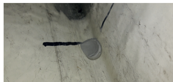
Leckreparatur mit Teroson Dichtband
