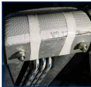
Die Rohre wurden mit Bolzen im U-Profil montiert.
