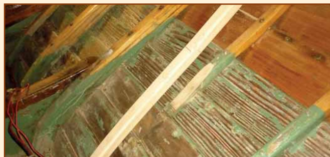
F-D511 neuer Spant vor dem Einbau
