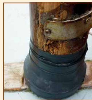
Hof Lomma, der Mast vor der Reparatur, mit dieser Stelle fing die Sanierung an.
