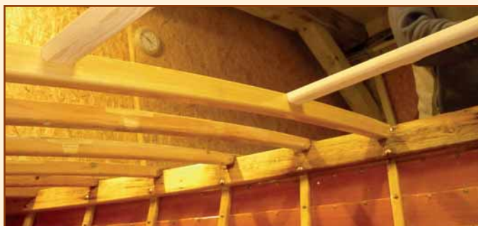
F-D511, neuer Aufbau der Decksbalken
