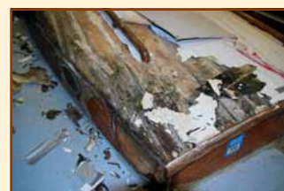
Hof Lomma, Aufbau nach Entfernen des Überzuges
