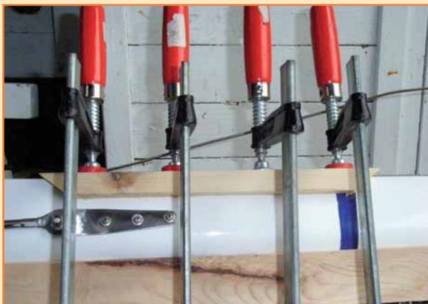
Bild 15: Profilleiste einkleben
