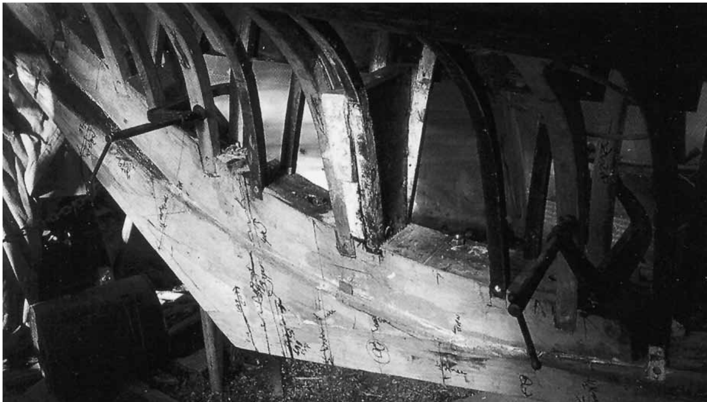
Fred Dowalo und Tom Maloney, Vater und Sohn, retteten EIRA vor der Säge. Doch die Rettung hatte ihren Preis: Sie ersetzen unter anderem fünf Planken auf jeder Seite, den Kiel, Steven Stevenknie. Die Abbildung zeigt bereits eine fortgeschrittene Phase der Arbeiten, das neue Holz ist am Platz, teilweise bereits die neuen Spanten (hier noch paarweise von Zwingen gehalten). Eine Restauration "bis auf die Knochen".
